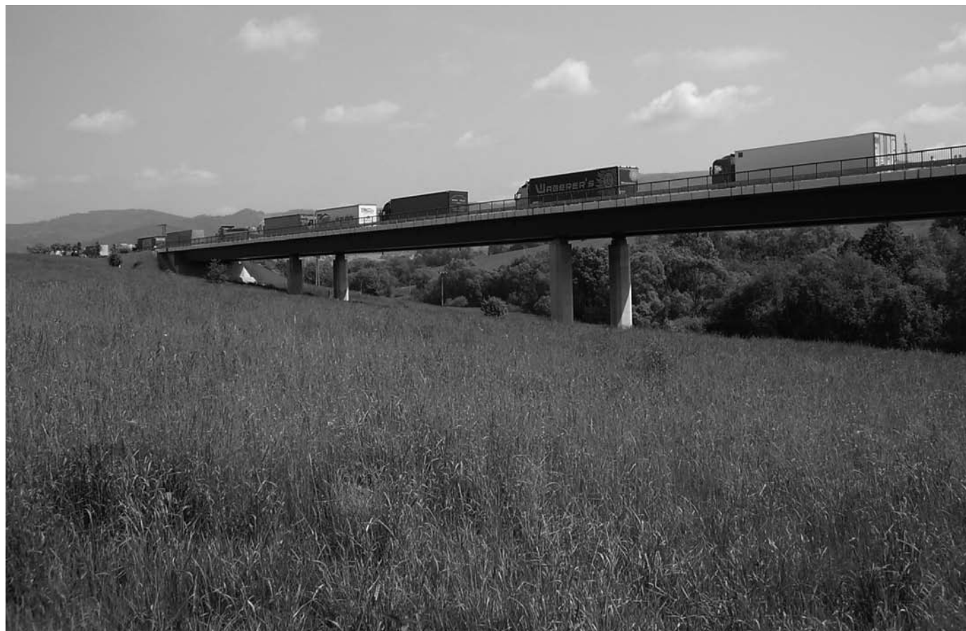
migrační trasa šelem pod estakádou mezi Jablunkovem a Mosty u Jablunkova
