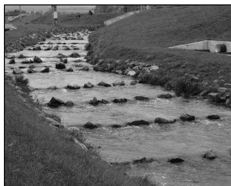
Obr. 47: Obtokový rybiovod s priečnymi líniami balvanov (foto V. Druga).
