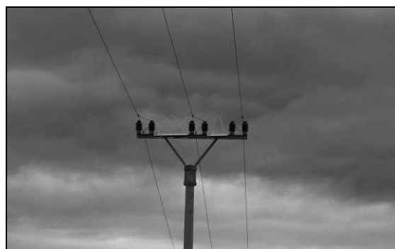
Obr. 38: Stĺp elektrického 22 kV vzdušného vedenia s trojuholníkovým usporiadaním konzol a vodičov (foto P. Urban).
