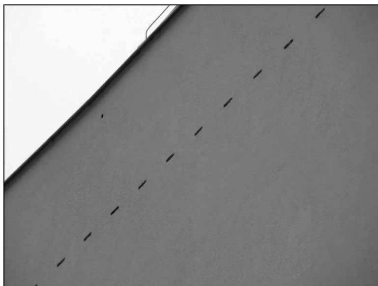
Obr. 49: Polystyrénové búdky netopiere, osadené do zateplenia polystyrénom (BAT-MAN, Slovensko) (Foto: CELUCH).
